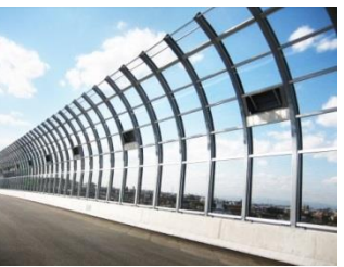
高速道路、遮音壁 アクリル、ポリカ 帯電防止防汚コート
